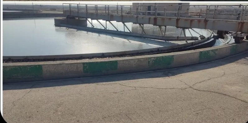
آغاز عملیات فاز دوم تصفیه خانه
